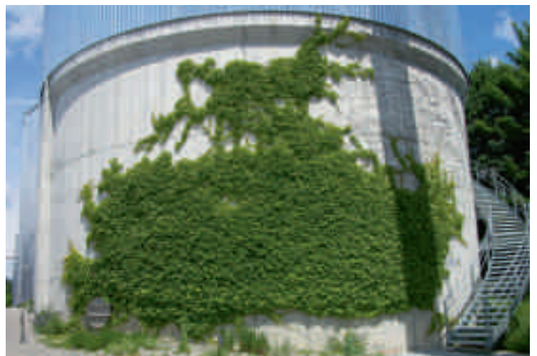
Fig. 3 Unversiegelte Flächen wie dieser Streifen rund um einen Gasspeicher auf dem Areal der ARA Thunersee lassen abfließendes Regenwasser versickern und bei Trockenheit verdunsten. Zudem bieten solche Flächen Boden für Kletterpflanzen oder Wildstauden, wovon Vögel und Insekten profitieren.
