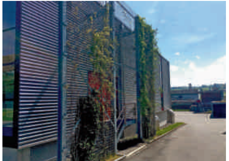
Fig. 2 Je nach Oberfläche können Pflanzen direkt an der Fassade oder, wie hier im Beispiel eines Areals des Abwasserverbands Morgental (AVM) in Steinach, an einer zusätzlich vor der Wand montierten Kletterhilfe hochklettern. Die Betreiber des Areals wissen um die Vorteile einer naturnahen Arealgestaltung und lassen ihr sorgfältig gepflegtes Areal nun durch die Stiftung Natur & Wirtschaft zertifizieren.
