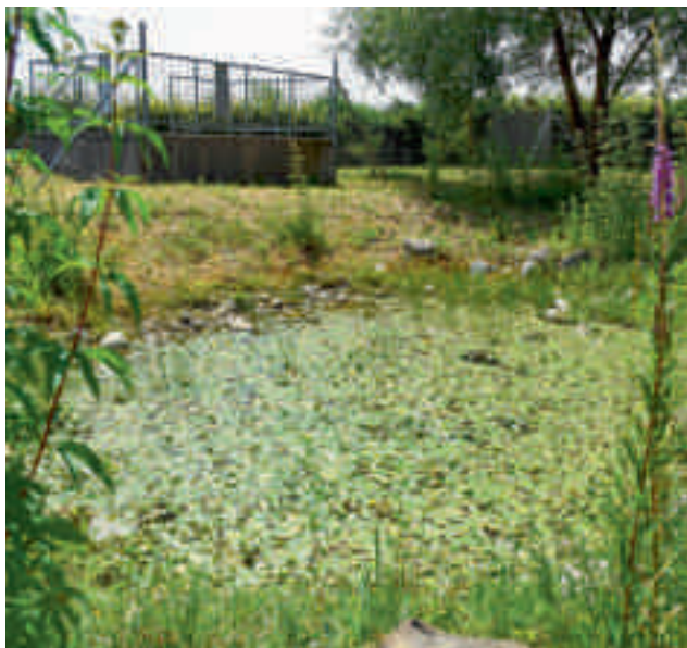
Fig. 6 Die IB Wohlen AG kennt sich mit dem Wasserkreislauf aus und nutzt zur Freude von wasserliebenden Insekten und Amphibien auf dem Areal ihres Reservoirs Hochwacht ein Retentionsbecken zur Versickerung des Dachwassers. Damit die Freude lange anhält und das Becken nicht zu schnell zuwächst, ist es wichtig, den Pflanzenbewuchs von Zeit zu Zeit einzudämmen.
