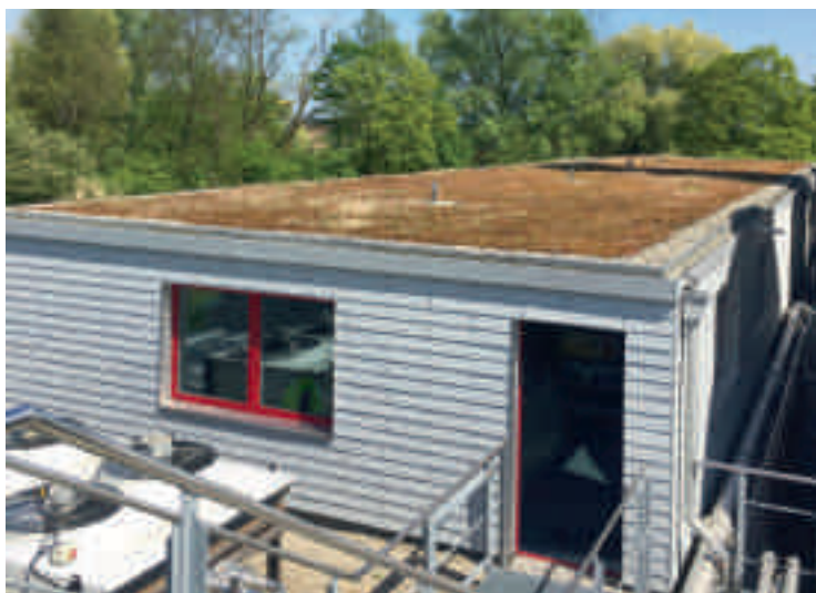
Fig. 4 Das Bürogebäude auf dem Areal Steinach des AVM wurde nachträglich begrünt, da sich die darunterliegenden Büroräume im Sommer zu stark erhitzten. Aufgrund der baulichen Voraussetzungen konnte nur eine geringe Substratschicht verwendet werden. Dies reichte jedoch bereits, um eine spürbare Abkühlung zu bringen.
