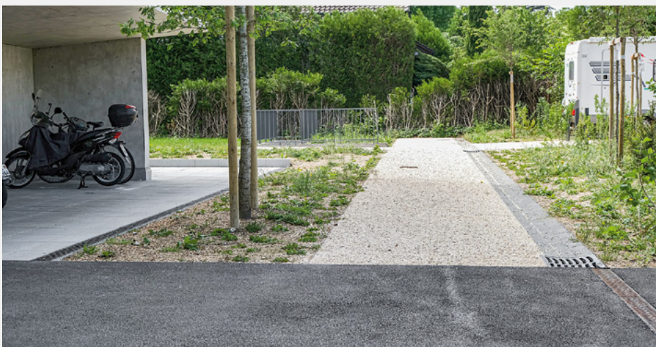
Fig. 7 Beispiel für die übermässige Verwendung von Bodenabläufen bei einer Aussenraumgestaltung in Genf.
