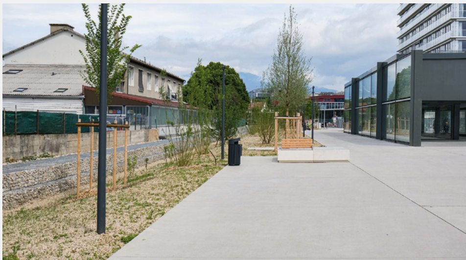
Fig. 2 In den öffentlichen Bereich des Bahnhofs Chêne-Bourg GE integrierte Regenwasserbewirtschaftung. (© Kanton Genf, Théo Gardiol)
