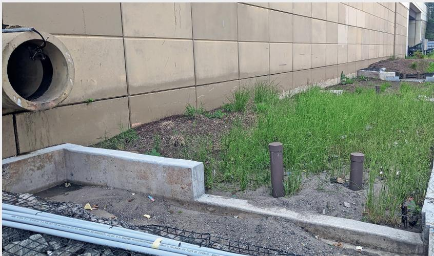
Fig. 3 Beispiel einer Blau-Grünen Infrastruktur in Philadelphia (USA). Nach einem heftigen Sturm wurden Sedimente und Abfall in die Infrastruktur eingeschwemmt und abgelagert. Diese muss nun gewartet werden, um die ordnungsgemässe Funktion zu gewährleisten.
