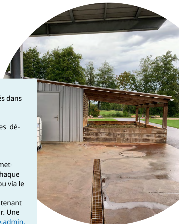
Aire de lavage avec système de traitement
