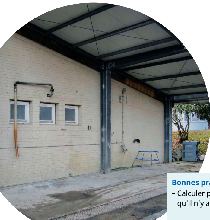
Aire de remplissage fixe avec sol en pente, toiture et évacuation des déversements dans un récipient de collecte
