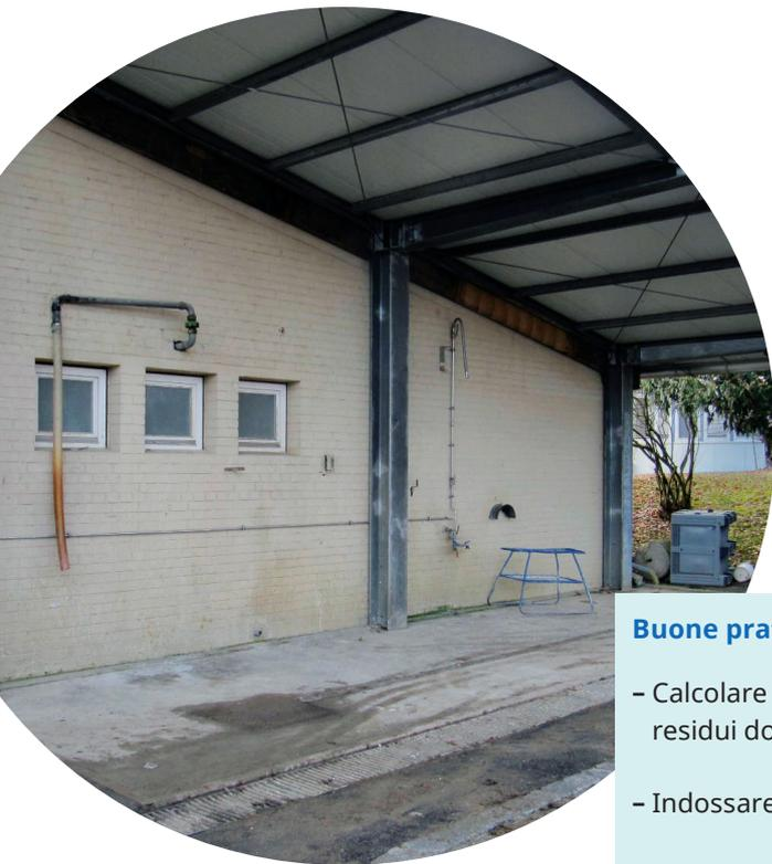
Piazza di riempimento fissa con pendenza, copertura e scarico in un contenitore idoneo
