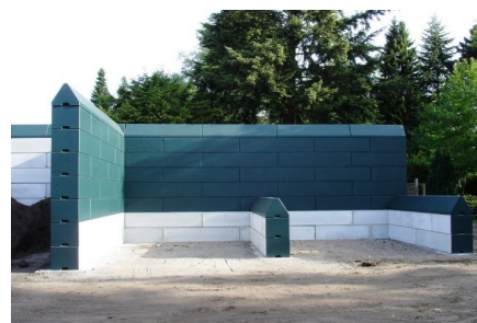
Figura 4: Area di deposito con parete tagliafuoco
