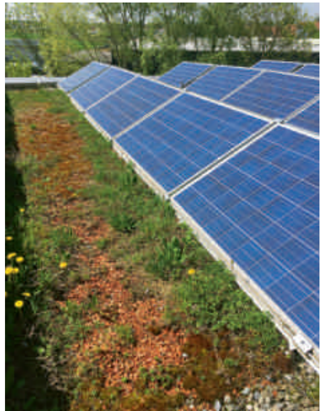
Fig. 5 Bei einem Energie-Gründach werden die Solarpaneele, wie hier auf einem Dach des AVM in Steinach, aufgeständert. Andere Systeme montieren die Paneele etwas erhöht, damit diese nicht durch die Vegetation bedeckt werden. Die Wuchshöhe der Vegetation kann zudem durch eine Reduktion der Substratdicke direkt vor den Paneelen beeinflusst werden [6].
