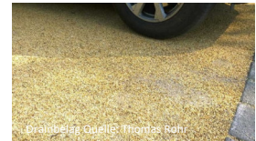
Wasserdurchlässiger Belag Quelle: Thomas Rohr
